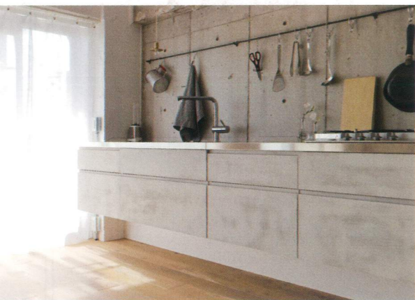
幅が3mを超えるキッチンは、床から浮かせてコンクリート壁に造作。扉は、木の質感を残しながらDIYでペイント。
